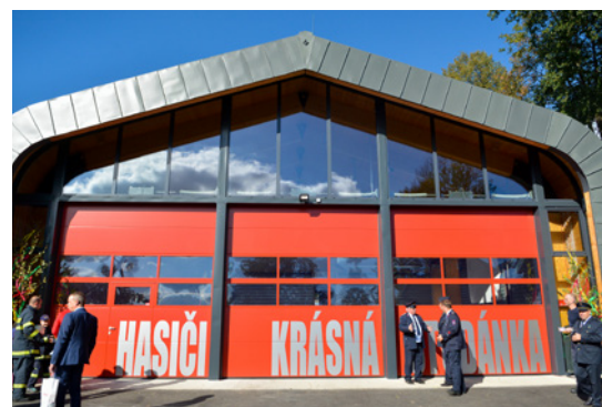
Cenu veřejnosti v soutěži Stavba roku Libereckého kraje 2019 získala hasičská zbrojnice v Krásné Studánce
