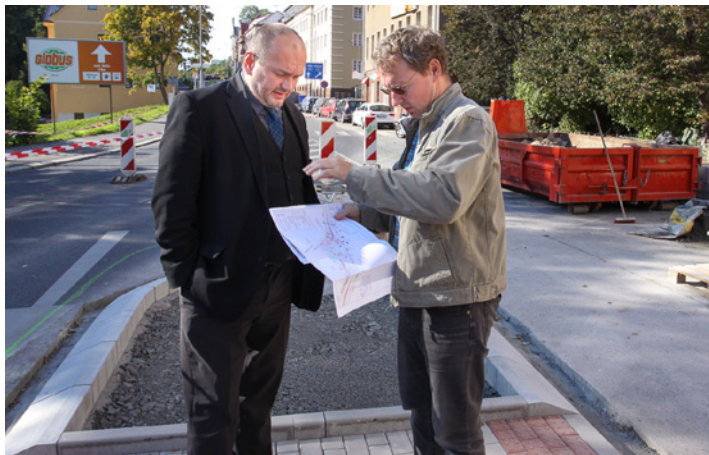
BEZPEČNÝ PŘECHOD. Během budování nového přechodu na rizikovém místě Sokolské ulice byli stavbu kontrolovat náměstek primátorky Jiří Rutkovský, který řešení problematických přechodů v Liberci dlouhodobě prosazuje, a dopravní specialista Vladislav Rozsypal. Foto Pavel Chmelík
