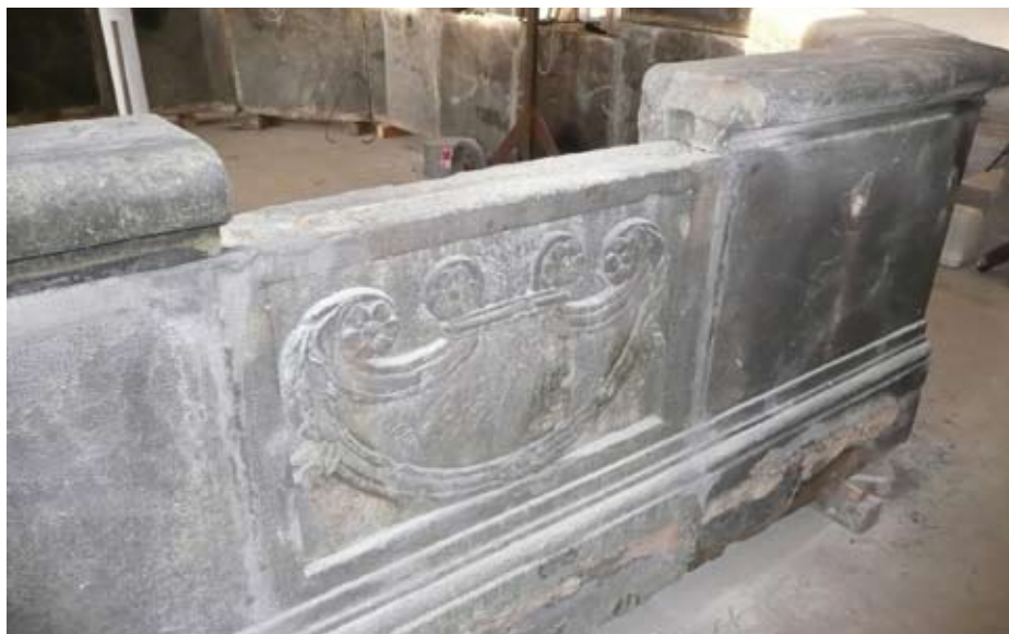
Jednotlivé zrestaurované díly Neptunovy kašny v restaurátorské dílně, odkud budou převezeny k montáži na náměstí Dr. E. Beneše. Kámen s reliéfem je jednou z dvou bočních desek vany kašny zdobené motivem s německými nápisy.
